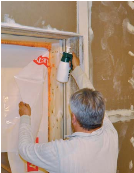
Ausschäumen der Bauanschlussfuge
