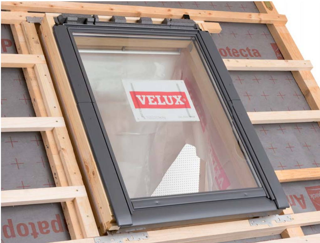
Vor der Montage der Unterdachschrürze
