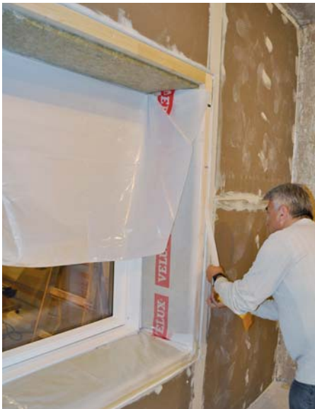
Laibungsdämmung und Anschluss der Dampfbremsen-Manschette
