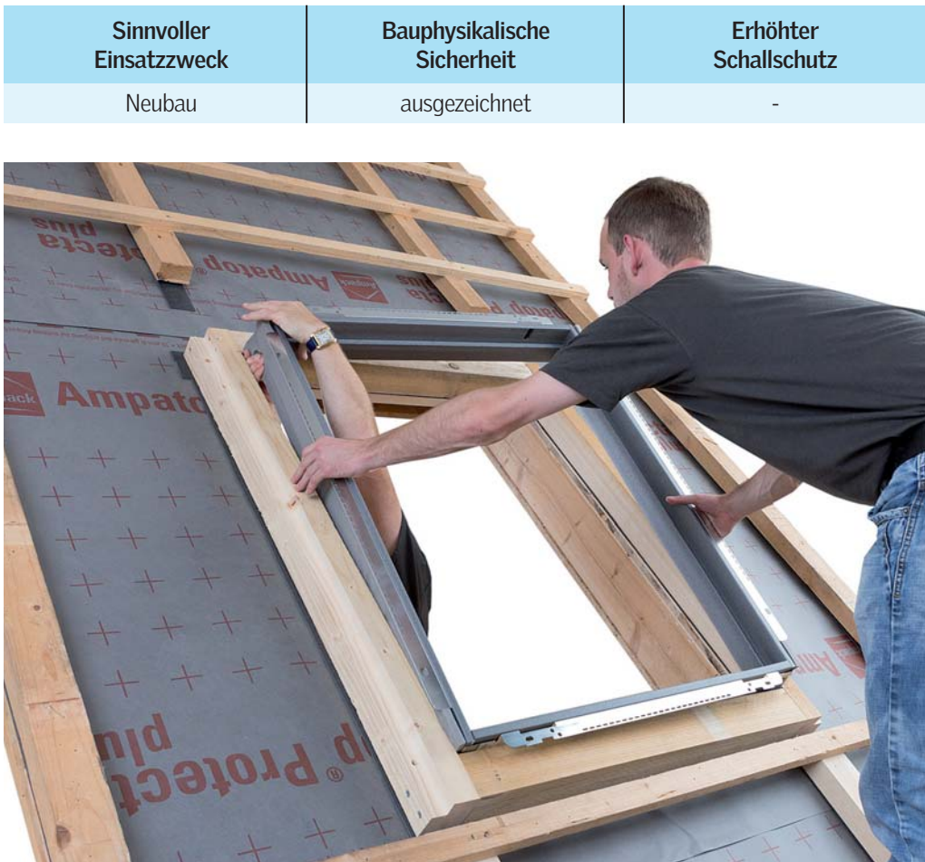
Einbau VELUX Wärmedämmrahmen
