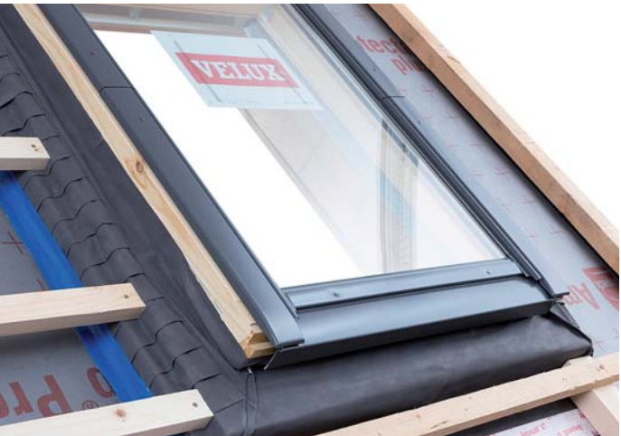
Unterdachschräge verklebt
