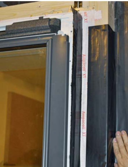
Staffelrahmen + selbstklebende Bitumenbahn
