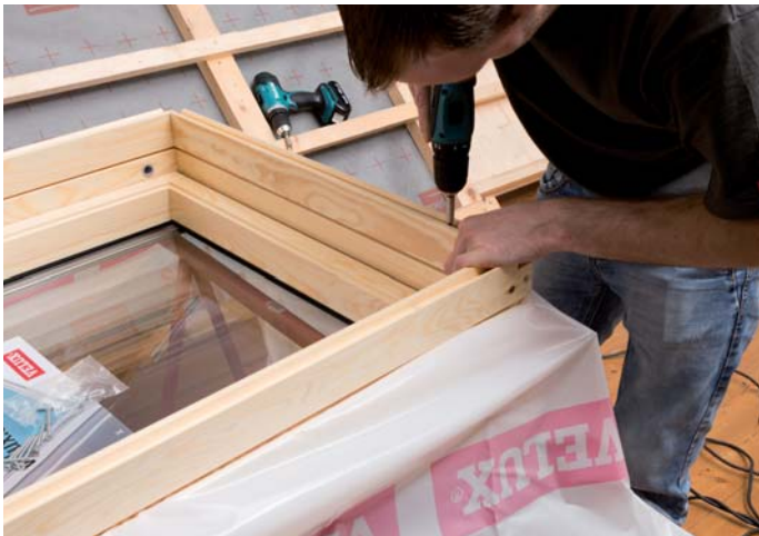
Einbau von Dampfbremsen-Manschette und Stockverlängerung
