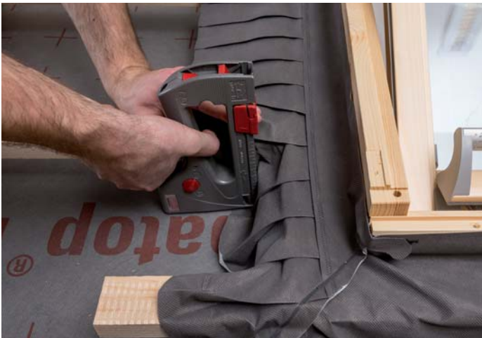
Montage der Unterdachschrürze
