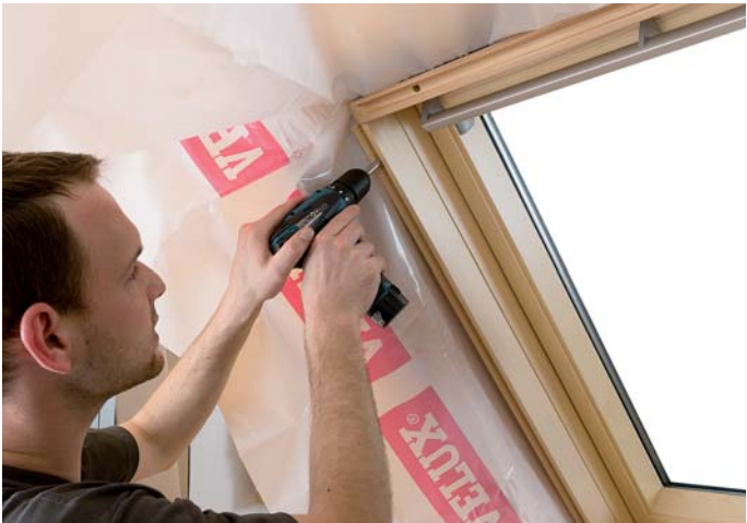
Montage Stockverlängerung und Dampfbremsen-Manschette
