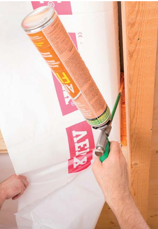
Ausschäumen der Bauanschlussfuge
